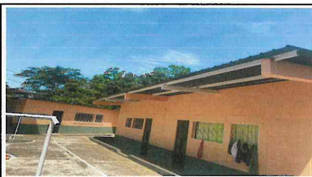
Foto 4: Falta de canales pluviales
